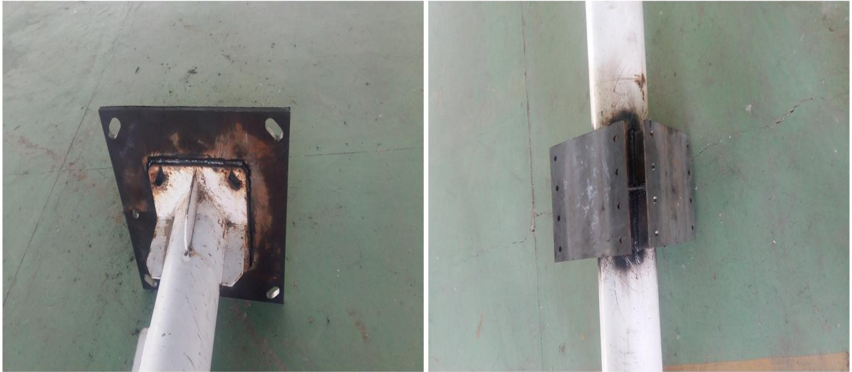
图2 篮球架支撑板换向板焊接示意图
